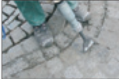
Aufstechen gebundener Fugen
